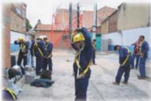
Personal equipándose para la realización de trabajo en torres.
