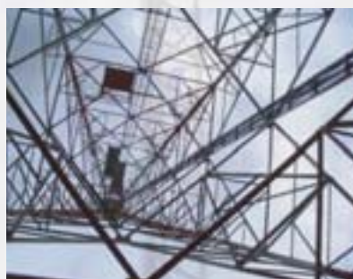
Plataformas de desplazamiento o líneas horizontales, posibilidades para asegurar los desplazamientos en torres muy anchas.
