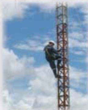
Piezas sueltas o ascensos difíciles pueden ocasionar la caída de un trabajador.
