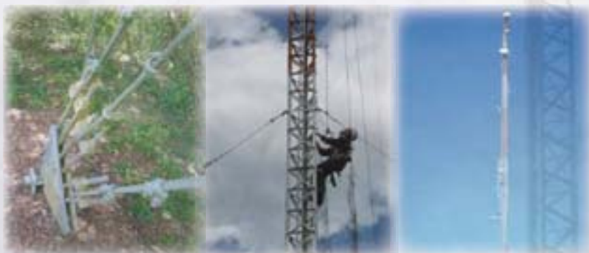
Torres riendadas y detalle del anclaje de las riendas.
