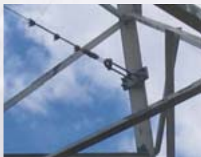
Plataformas de desplazamiento o líneas horizontales, posibilidades para asegurar los desplazamientos en torres muy anchas.
