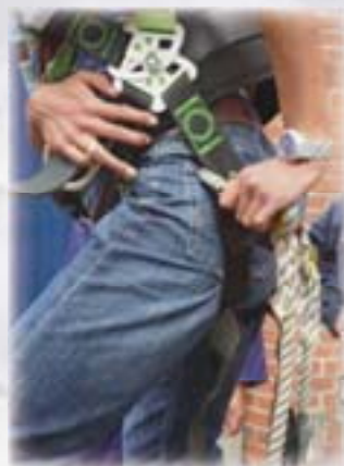
Arneses de cuerpo completo para trabajo en torres, que incluyen argollas para las conexiones respectivas.
