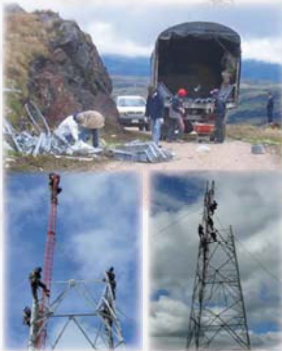
Montadores de torres cuando llegan con el material y durante el proceso de armado.
