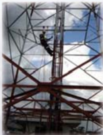
Técnica de posicionamiento y suspensión, incluye la protección adicional de la eslinga con absorbente de choque.
