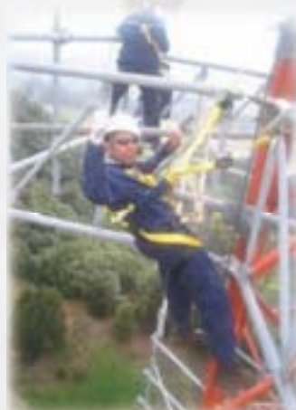
Técnica de posicionamiento y suspensión, incluye la protección adicional de la eslinga con absorbente de choque.
